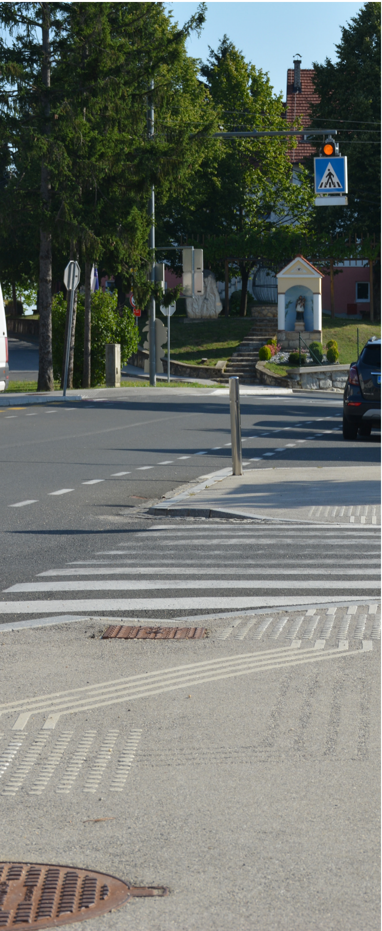
Slika 8: Izsek prometne ureditve v naselju Cerkvenjak z urejenimi površinami za sselepe in slabovidne ter za gibalno ovirane osebe
